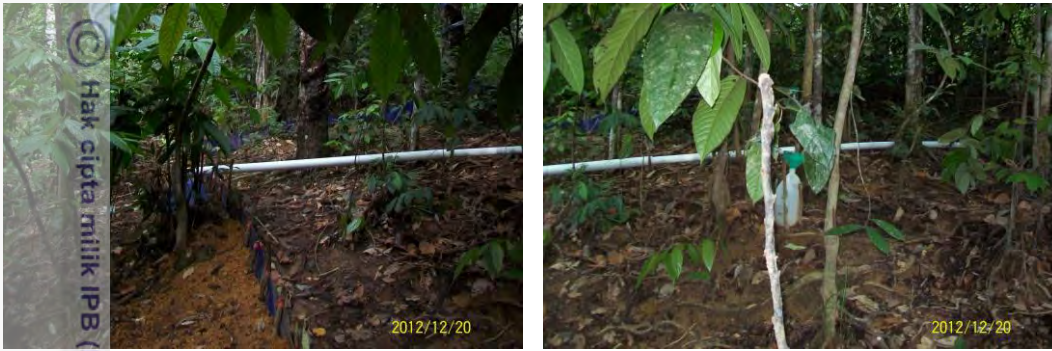
Gambar 41 Pemasangan paralon untuk mengeluarkan aliran bawah permukaan pada hutan karet (Plot 7)
