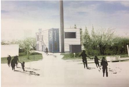
Die Planung des über Landesmittel finanzierten BHKW konnte in 2016 abgeschlossen werden. Das BHKW wird über eine Leistung von 4,4 MW<sub>el.</sub> verfügen und in der Lage sein, bis zu 45 % des von der UMG benötigten elektrischen Stroms und rund 30 % der benötigten Wärme zu produzieren. Die Errichtung des Gebäudes und der technischen Infrastruktur erfolgt im Jahr 2017. Die Inbetriebnahme und Einspeisung der erzeugten Energie ist für das Jahr 2018 vorgesehen.
