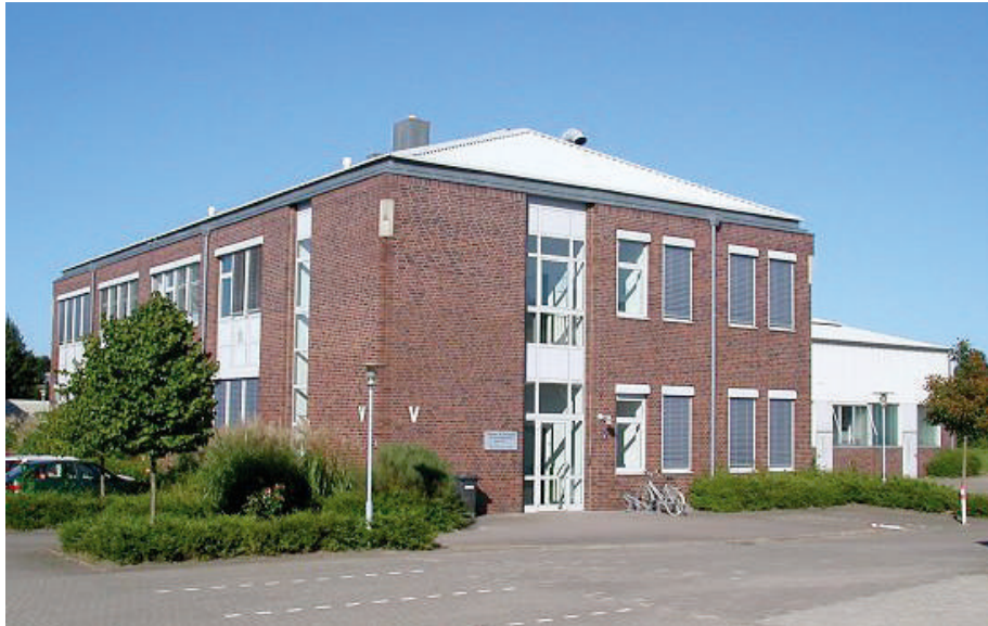
Das Hauptgebäude der Außenstelle Vechta.
