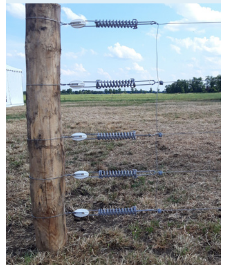
Wolfsabweisender Zaun für Rinderweide: Fünf stabile Drahtstränge und Strom sollen verhindern, dass Wölfe den Zaun überwinden.
