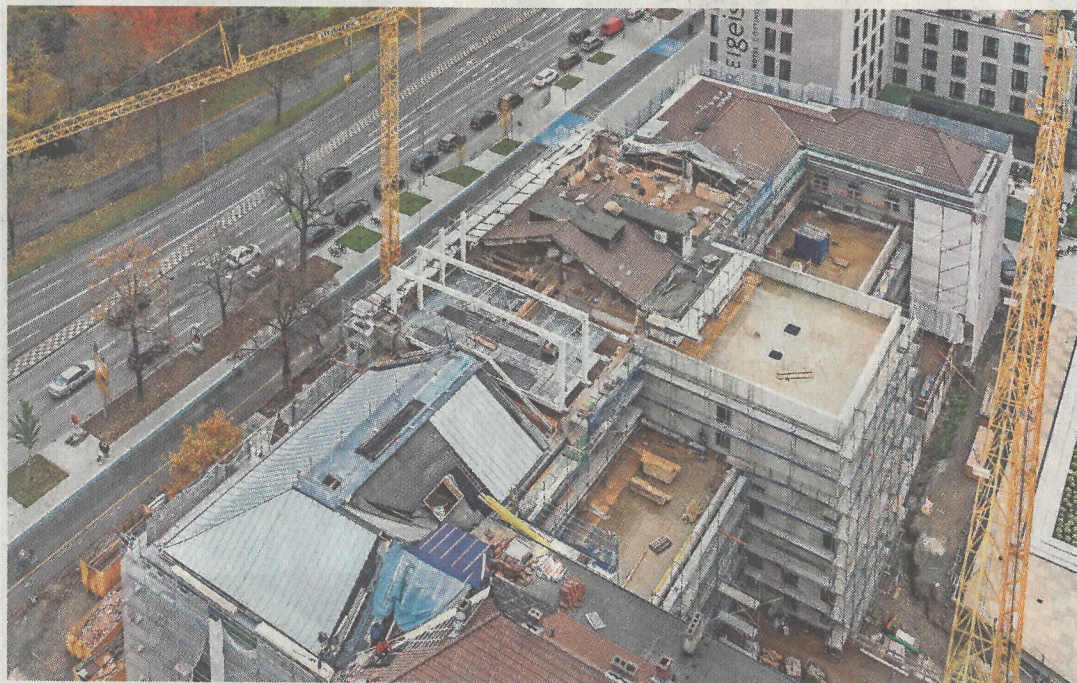
Baustelle für das Forum Wissen mit dem direkt angeschlossenen Thomas-Oppermann-Kultur-Forum im Nordflügel.
