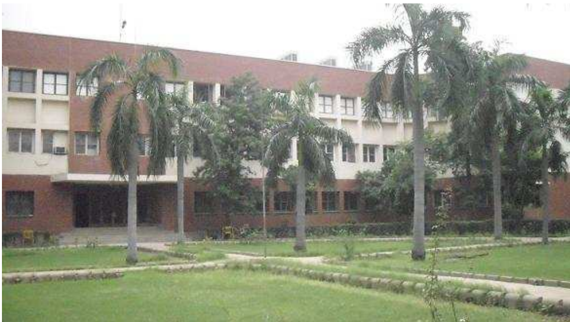
Straßenansicht des DSE Gebäudes. Kantine und Tee-Imbiss befinden sich auf der anderen Seite des Gebäudes.
