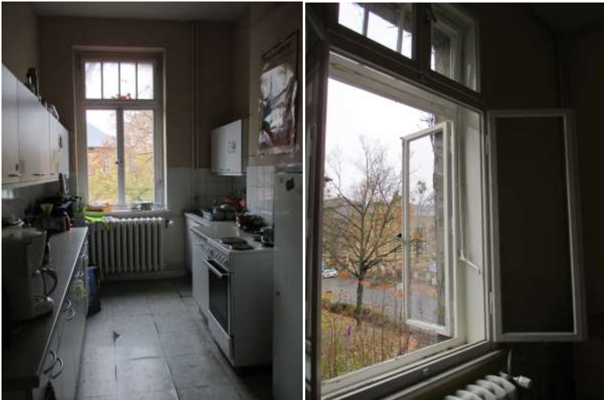
Küche im Erdgeschoss
